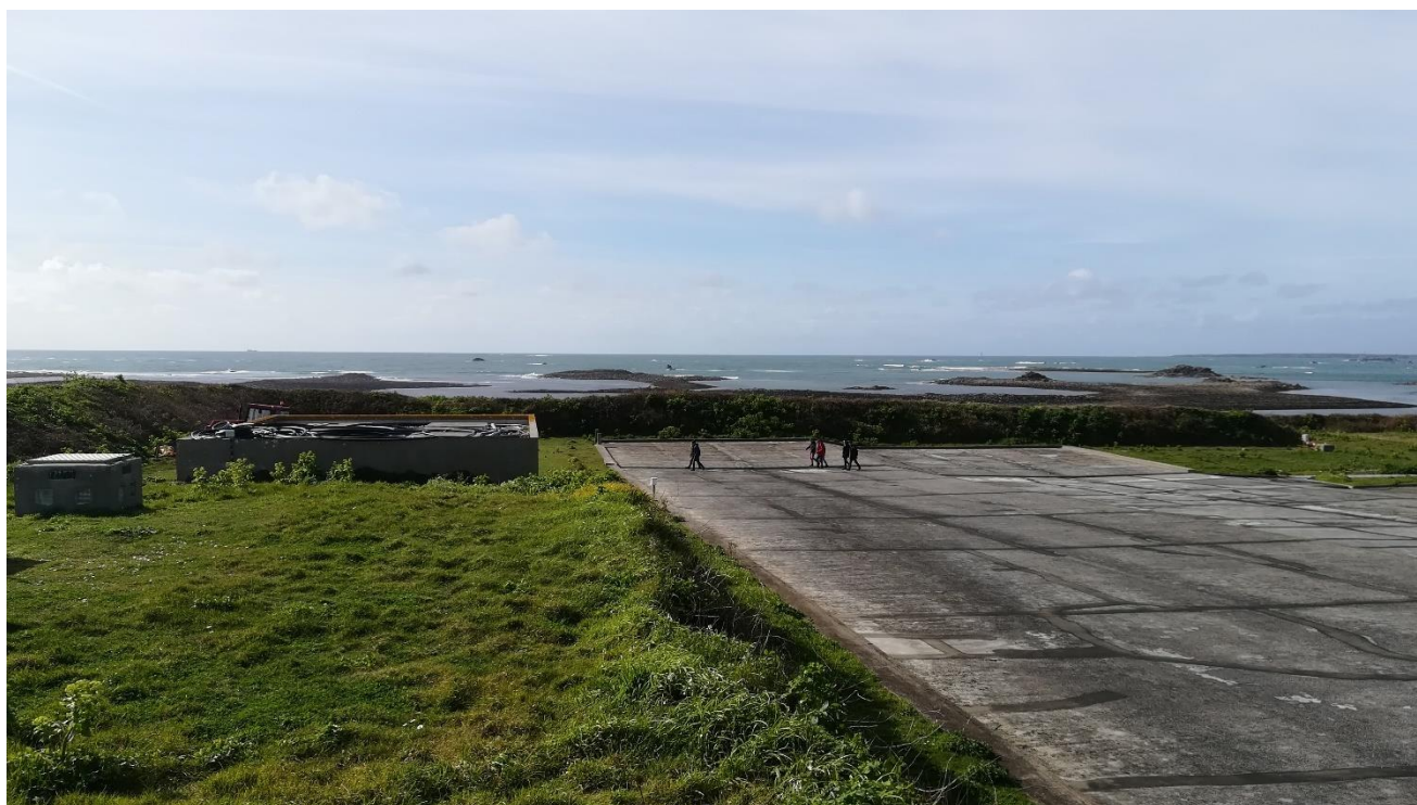
Figure 6 : Vue de l'impluvium de Molène - à gauche le local technique et à droite la dalle béton de collecte d'eau pluviale
